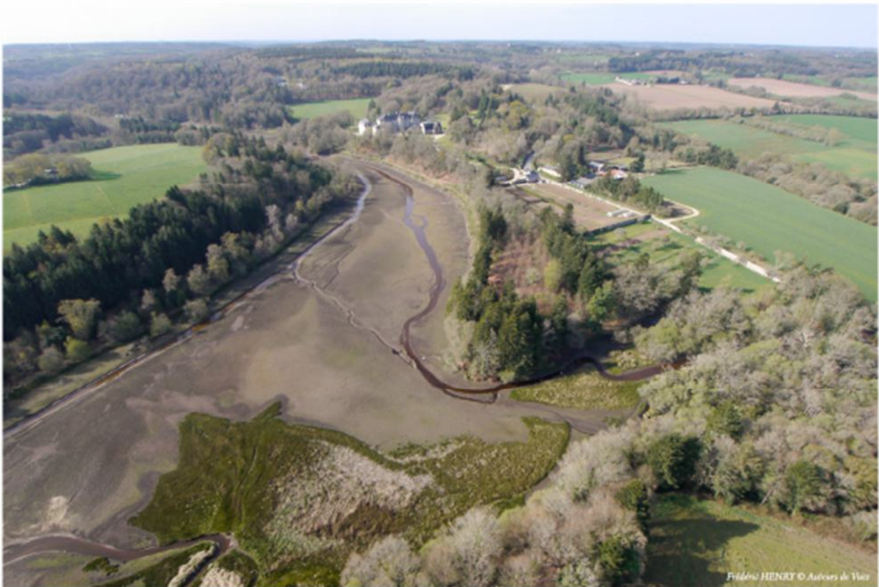
Figure 8 : Vue aérienne du ruisseau de Landordu en avril 2012, avec un tracé rectiligne visible sur la gauche du cliché photographique (©HENRY F. ; SMEIL)
