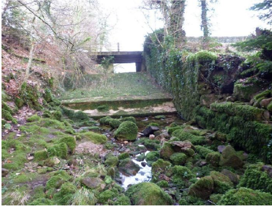
Figure 4 : Vue aval du déversoir le 10/01/2012 (©OFB)
