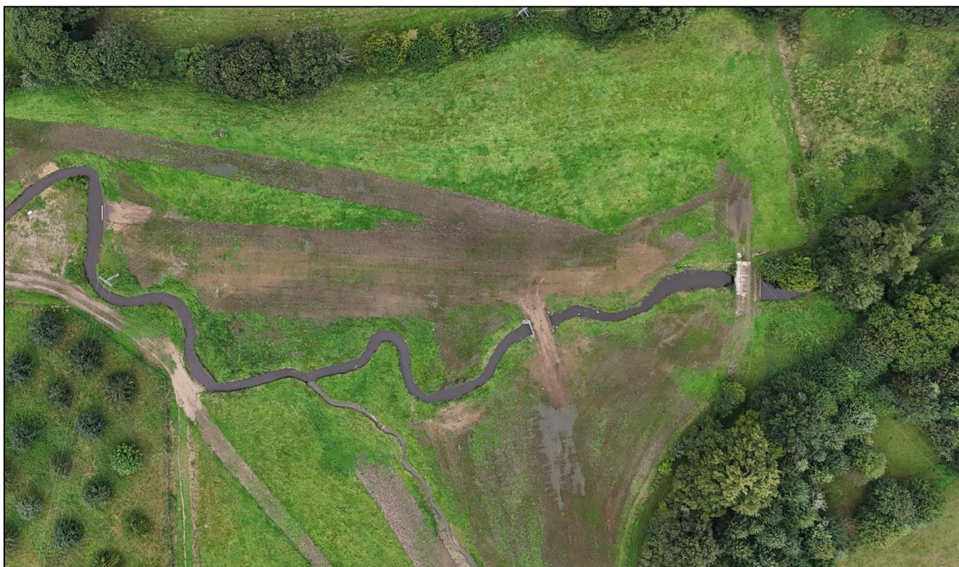
Vue de la Loirance et de la Chesnardière après travaux.
