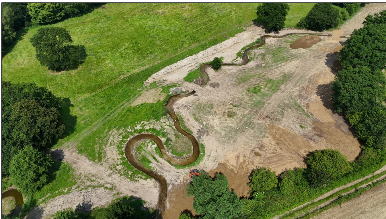
Vues pendant travaux.
