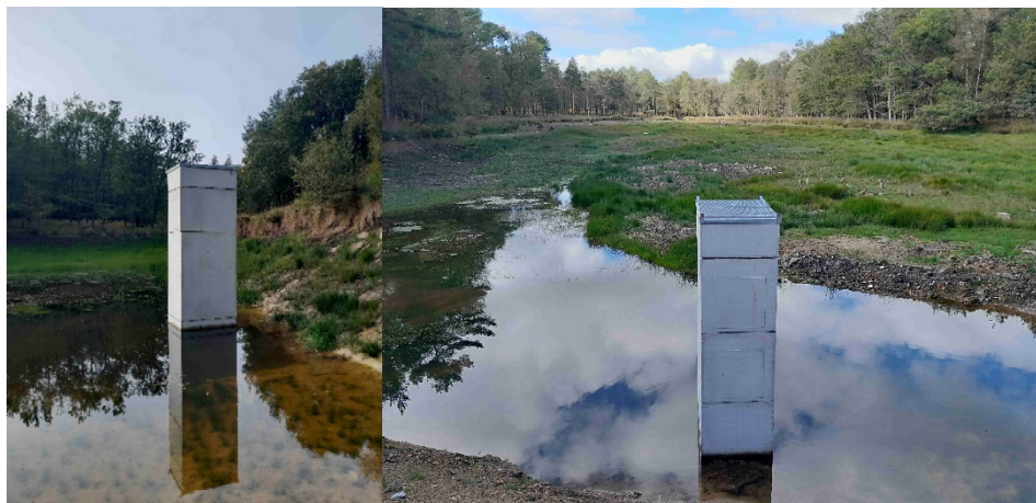
Figure 6 : Plan d'eau en cours de remplissage suite à l'installation de moines sur des plans d'eau préexistants (© HUBERT & LE BIHAN, OFB, 2024 ; Forêt de Lanouée, 56).
