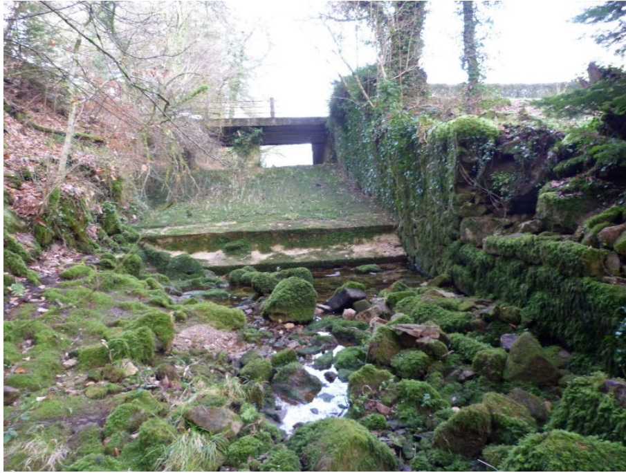
Figure 4 : Vue aval du déversoir le 10/01/2012 (©OFB)
