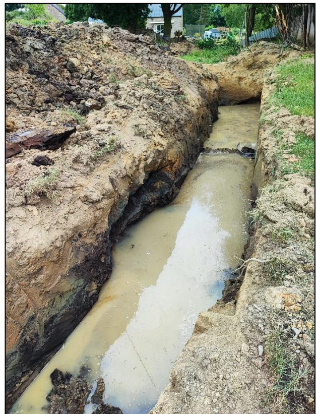
Suppression du busage et des drains.
