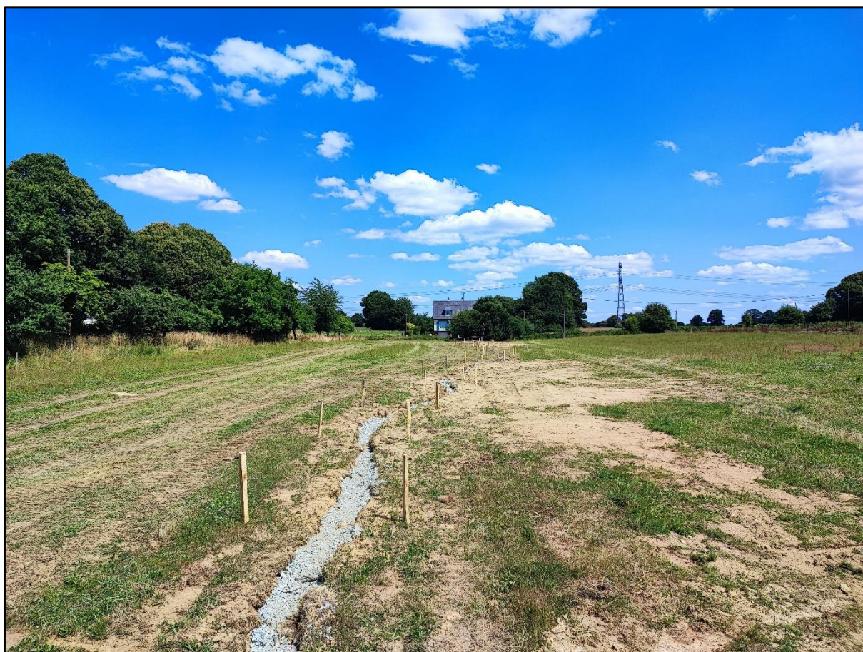
Apport granulométrique, installation de franchissement et des clôtures.
