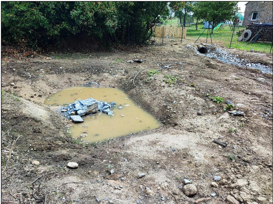
Seconde mare collectant le pluvial de plusieurs bâtiments et d'un chemin d'exploitation.
