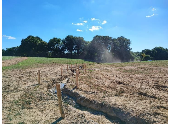
Photos pendant les travaux, création du talus avec la terre évacuée pour la création du nouveau lit.
