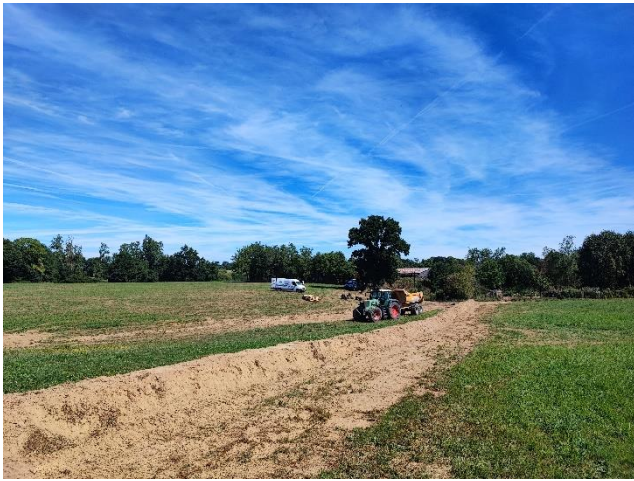
Photos pendant les travaux, création du talus avec la terre évacuée pour la création du nouveau lit.
