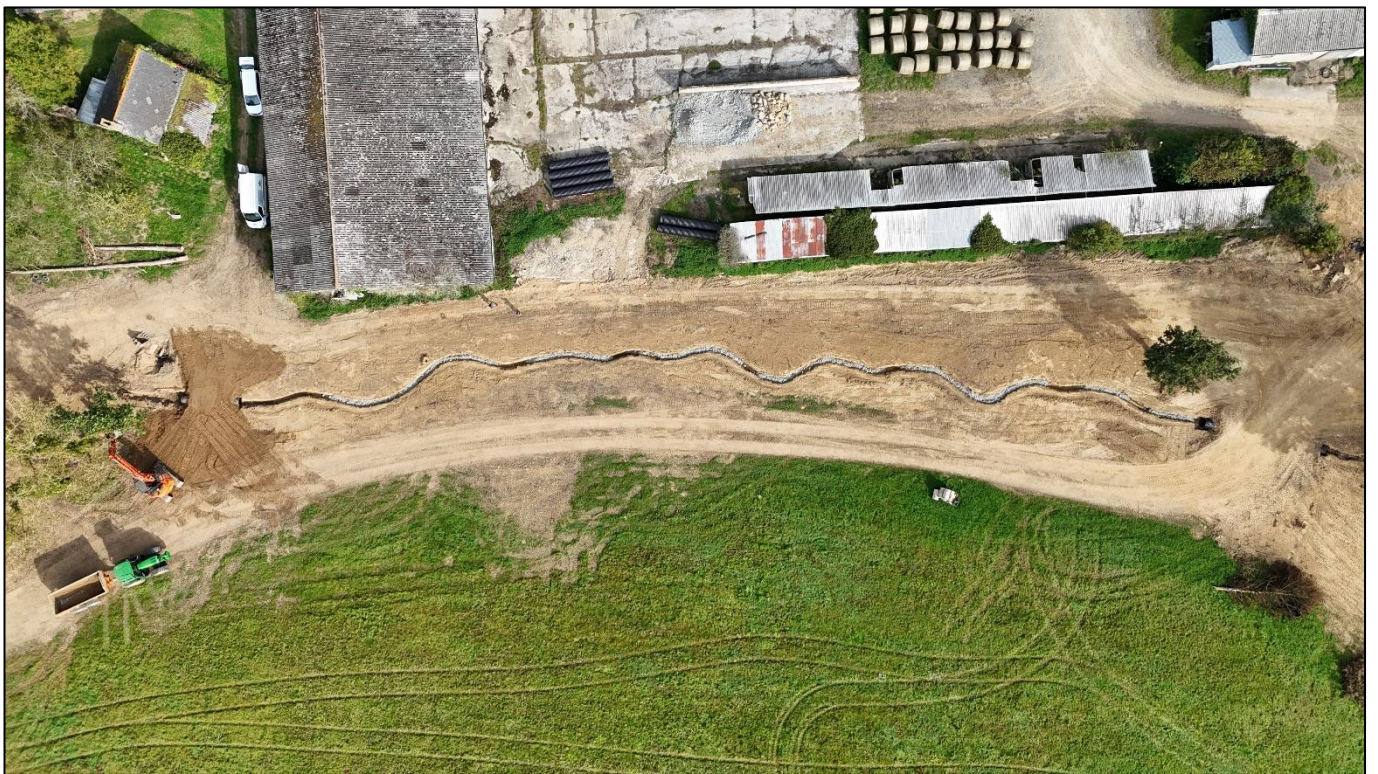
Vue aérienne avant et pendant les travaux.
