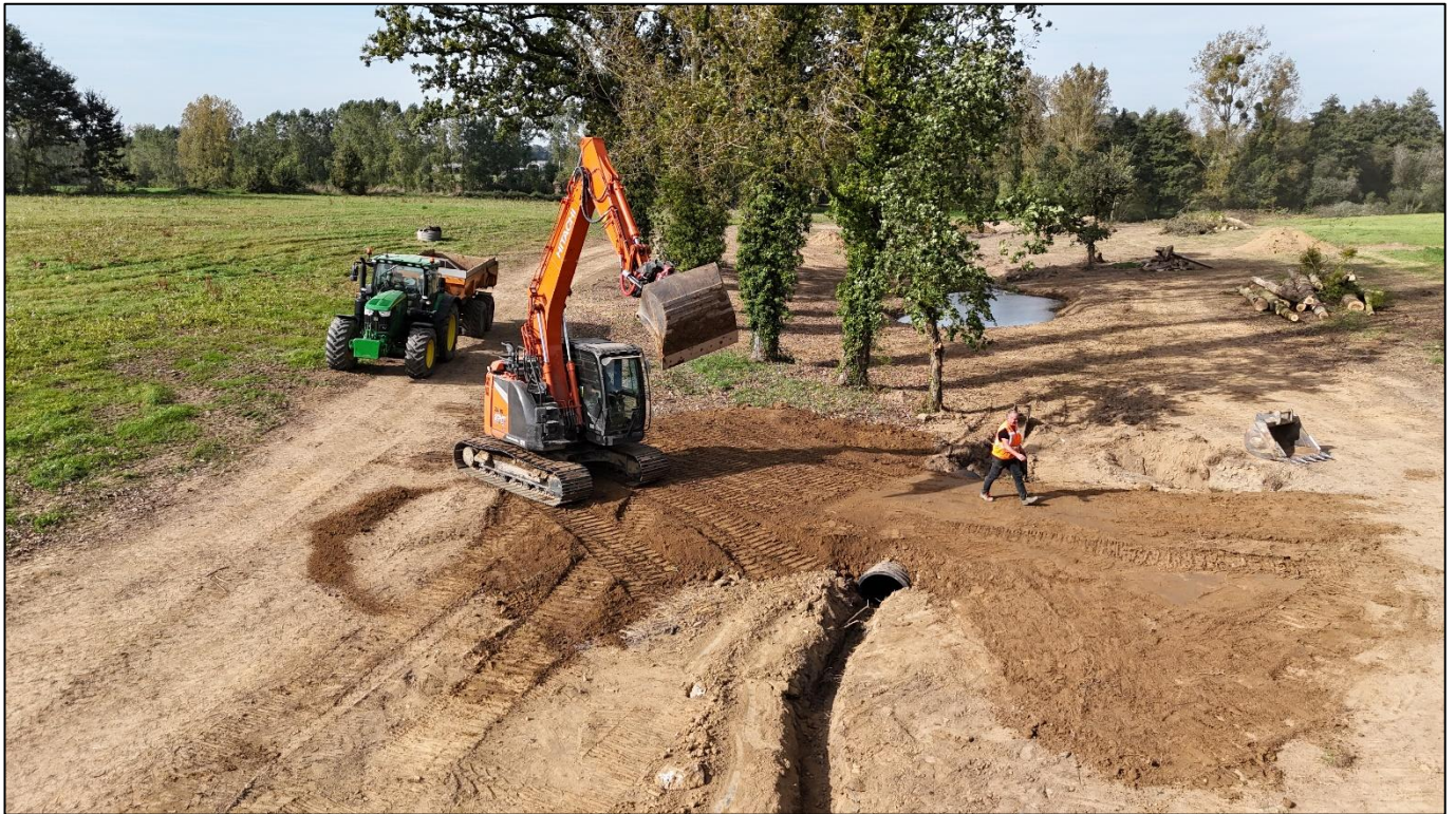
Mise en place d'un franchissement agricole
