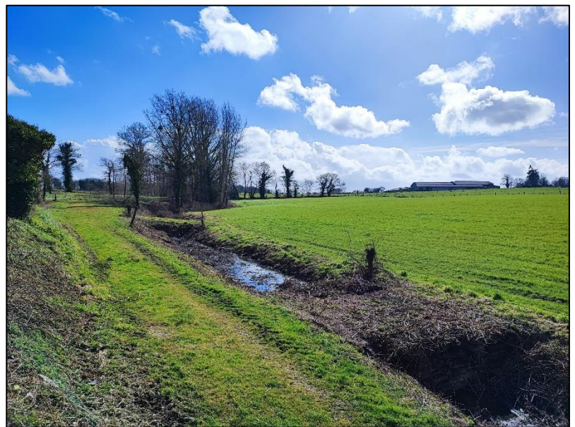
Lit mineur avant travaux
