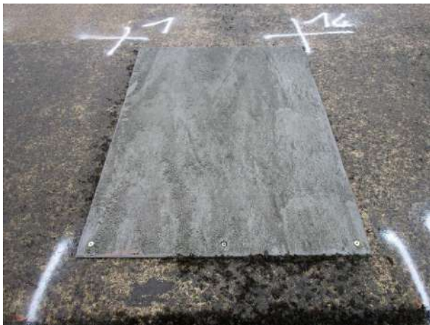
Photo n°27 : Novaplak bloc B le 13 décembre 2021
