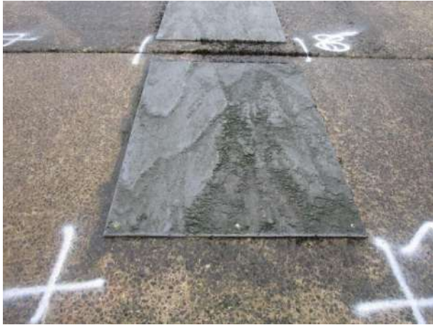
Photo n°25 Novaplak bloc A le 13 décembre 2021
