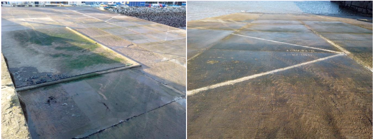
Photographie 4 : Avant le traitement à 2,5% (12 janvier 2016)
