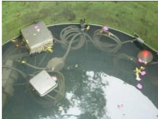
A l'inverse, en mai 2013, le niveau de l'eau dans la cuve était plus bas que la poire de niveau basse et le filtre à zéolithe était à sec. Raison possible : la poire de niveau bas est restée bloquée en position horizontale.
