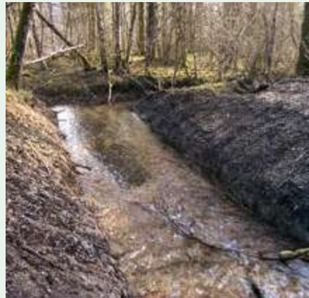
L'ouverture de cette digue est légèrement sous-dimensionnée, la restauration complète du ruisseau sera plus longue.
