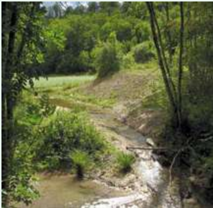
Un an après l'ouverture de la digue, le ruisseau retrouve un équilibre.
