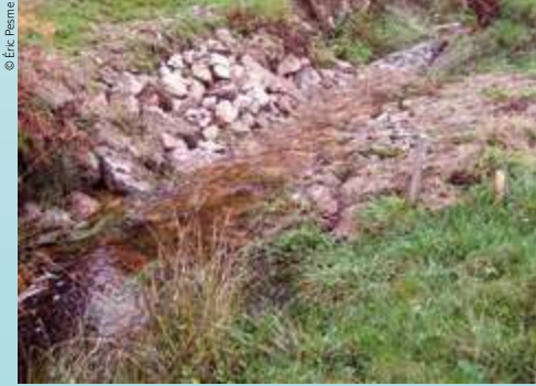
Rampe en pierres granitiques sur le ruisseau de Vaucorniau (Brassy, 58). 23 rampes ont été installées sur 450 mètres.
