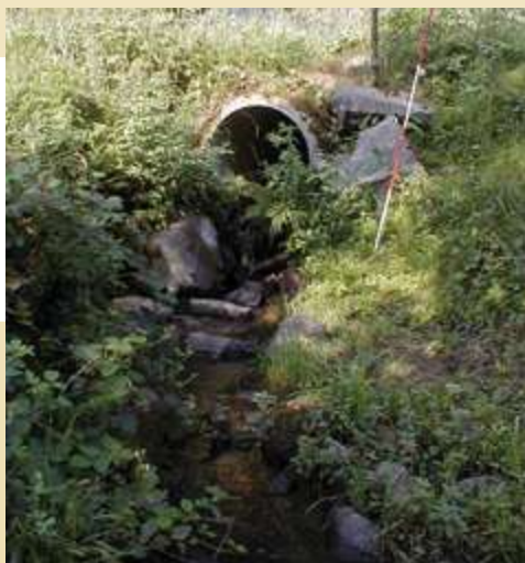
Chute aval générée par le passage busé du ruisseau de la Saint-Nicolas (90) avant son aménagement.
