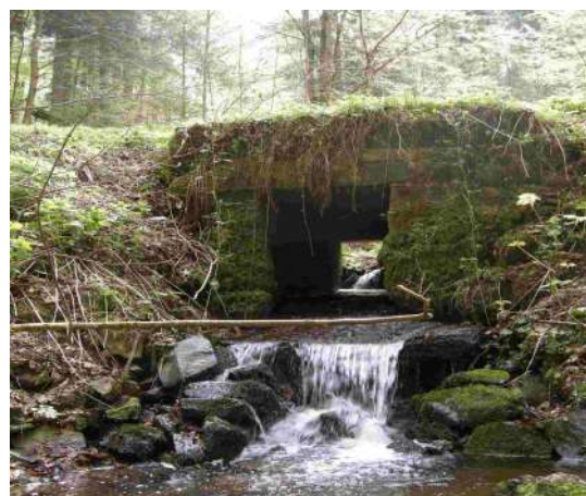
Photographies 1 et 2 : exemples d'ouvrages hydrauliques sous voie communale et voie forestière, incompatibles avec le principe de continuité écologique (source : CETE de l'Est).
