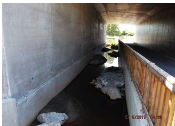
Vue depuis l'amont de l'ouvrage achevé et mis en service
