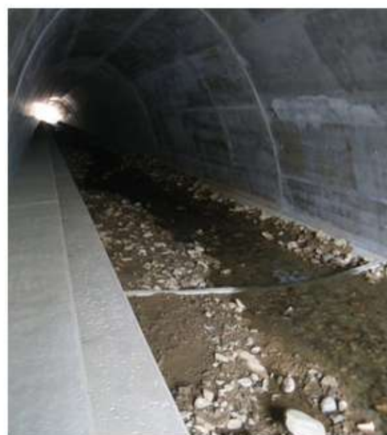
Photographies 11, 12, 13 et 14 : Exemples d'aménagements piscicoles dans des ouvrages hydrauliques fermés : seuils (ou déflecteurs ou barrettes) de dissipation de l'énergie hydraulique, de stabilisation du substrat, de concentration des écoulements à faibles débits, créant des conditions compatibles avec les capacités de nage et de saut des poissons (sources : Onema Délégations Interrégionales Sud-Ouest et Rhône-Alpes).
