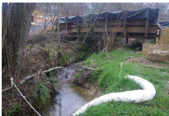
Photographie 6 : exemple de pont provisoire mis en place en phase chantier, préservant le lit mineur et les berges du cours d'eau (source : Onema, Délégation Interrégionale Sud Ouest).
