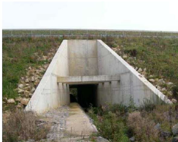
Tête de l'ouvrage.
