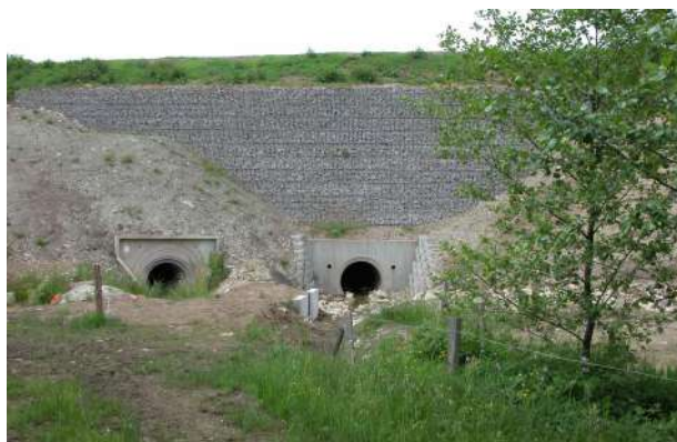
Photographie 17 : Mur en gabions pour soutenir le remblai et réduire la longueur de couverture
