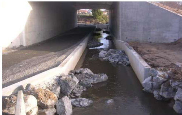
L'ouvrage en cours d'aménagement
