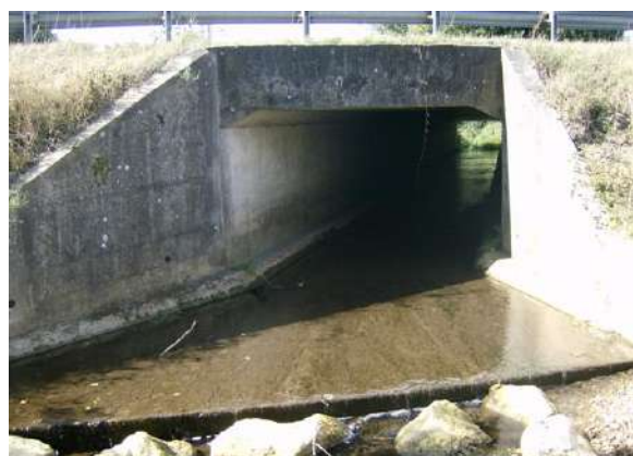
Photographies 3 et 4 : exemples d'ouvrages routiers mal calés ou mal dimensionnés, engendrant une interruption de la circulation des poissons : vitesses de courant supérieures à la capacité de nage des poissons ; étalement de la lame d'eau et absence de rugosité au fond du radier (sources : Onema, Pôle écohydraulique et Service Départemental de la Gironde).
